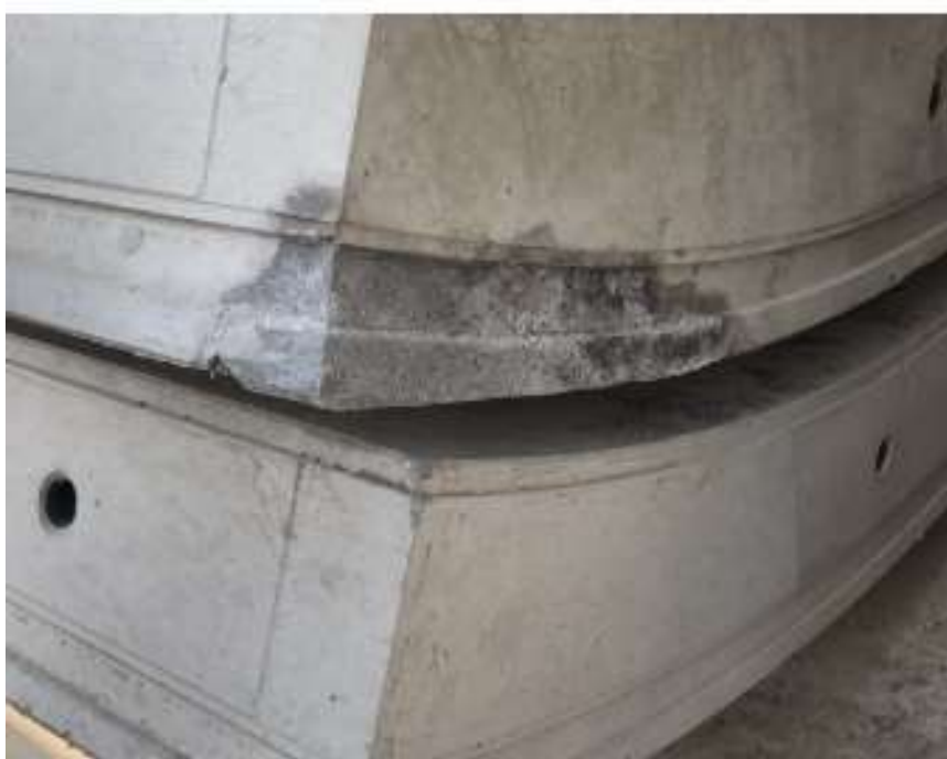
图 1.管片边角部位快速修补
