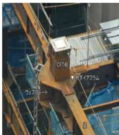
第一代专利-外环板式梁柱节点
